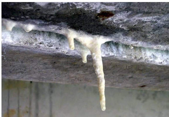
Рис. 1. Общий вид сталактитов на нижней поверхности бетонных конструкций моста через р. Нерль: слева – сталактиты белого цвета, справа – ожезненные сталактиты желтого цвета
