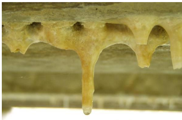
Рис. 1. Общий вид сталактитов на нижней поверхности бетонных конструкций моста через р. Нерль: слева – сталактиты белого цвета, справа – ожезненные сталактиты желтого цвета
