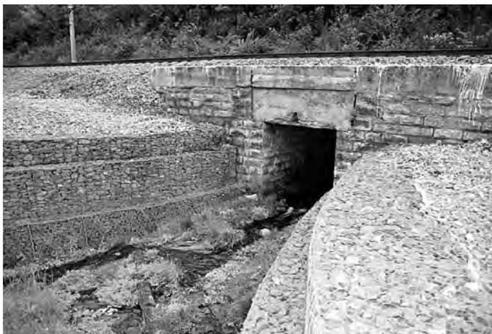
Рис. 3. Выход потока из тоннеля. Слева и справа – защитные габионные сооружения
