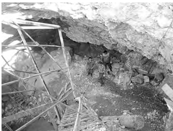
Рис. 3. Разрушение лестниц при обвале на входе в пещеру Голубинский Провал (2012 г.). Фото Е.В. Шаврина
