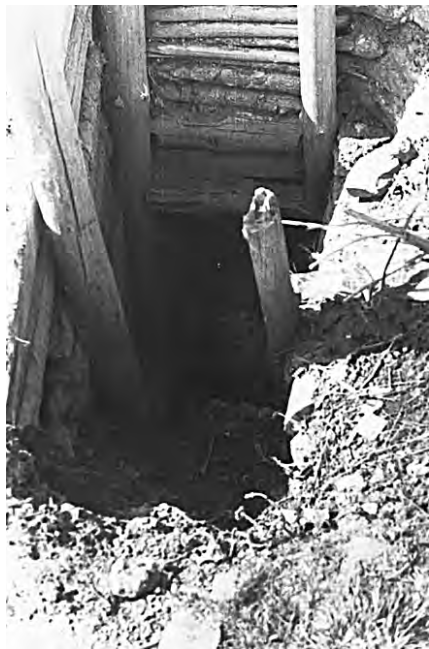
Рис. 1. Старый разрушенный вход в пещеру
