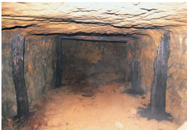
Рис. 2. Участок выработки с сохранившейся крепью
