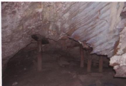
Рис. 19. Остатки водотранспортной системы каптажа источников. Транзитные трубы и накопительные ванны с элементами деревянного крепежа потолка
