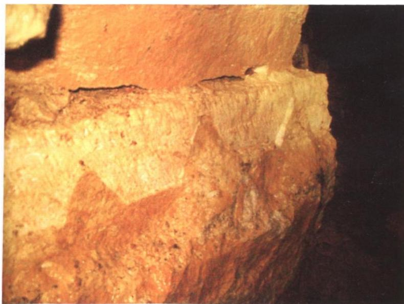
Рис. 7. Следы рабочего инструмента в каменоломне Рыбинская-3 (Собака-1)
